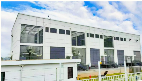
图3 110kV 庆云变电站实景图
